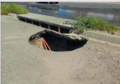
Este socavón sobre el Blvd. Solidaridad nació como un bache; pero ahora amenaza con extenderse sin previo aviso sobre toda la ruta. El año pasado ocurrieron dos accidentes en ese mismo lugar. ¿Se esperará una tragedia irreparable para atenderlo?
